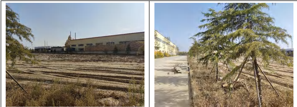
施工生产生活区
